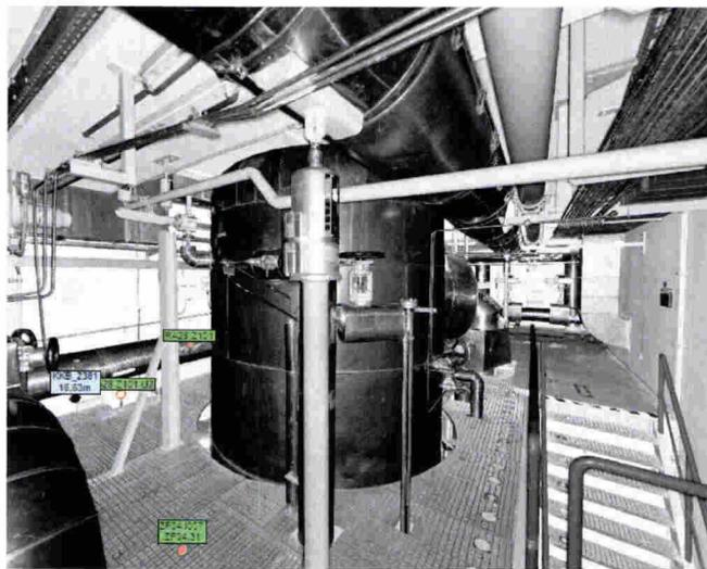
Abbildung 1: Blick auf den Hilfsdampferzeuger in Raum F04.31 auf Ebene +15,00 m
