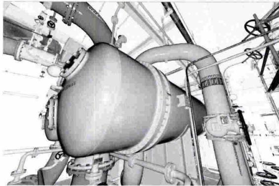
Abbildung 44: Blick auf den Zwischenkühler Betriebskühlkreislauf II VF12 B101 in Raum F01.38 auf der Ebene - 2,50 m
