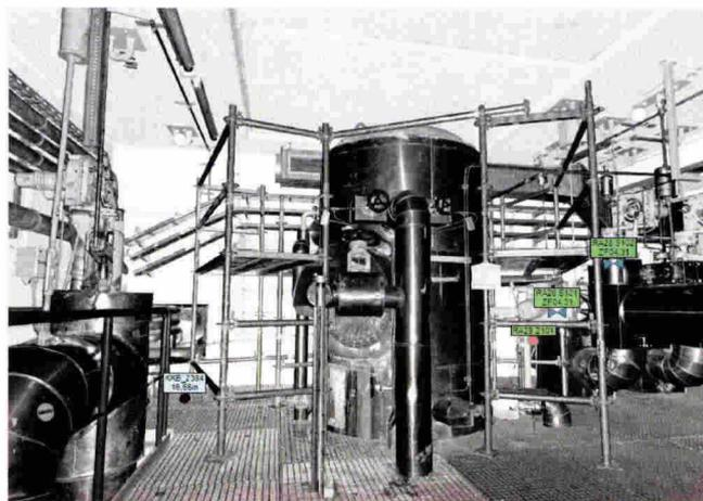
Abbildung 4: Blick auf den Stopfbuchsdampferzeuger in Raum F04.31 auf Ebene +15,00 m und die darüber liegende Montageöffnung
