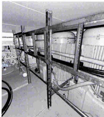
Abbildung 33a: Blick auf den Turbinenhauptölbehälter SC10 B001 im Raum F04.30 auf der Ebene +15,00m.
