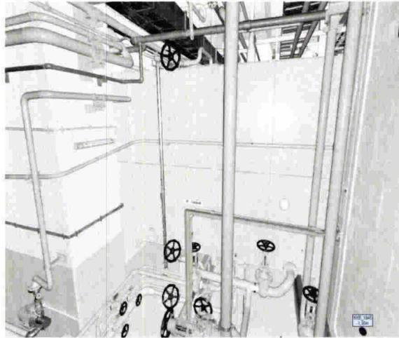
Abbildung 34a: Blick auf den Turbinenölablassbehälter SC20 B101 in Raum F01.39 auf der Ebene - 2,50 m
