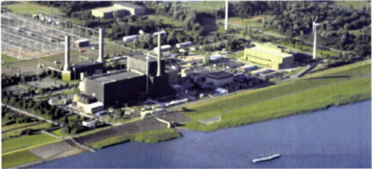
Abbildung 2-1: Kernkraftwerk Brunsbüttel, Fotografie des Kraftwerks von Südwest nach Nordost [VAT 12]
