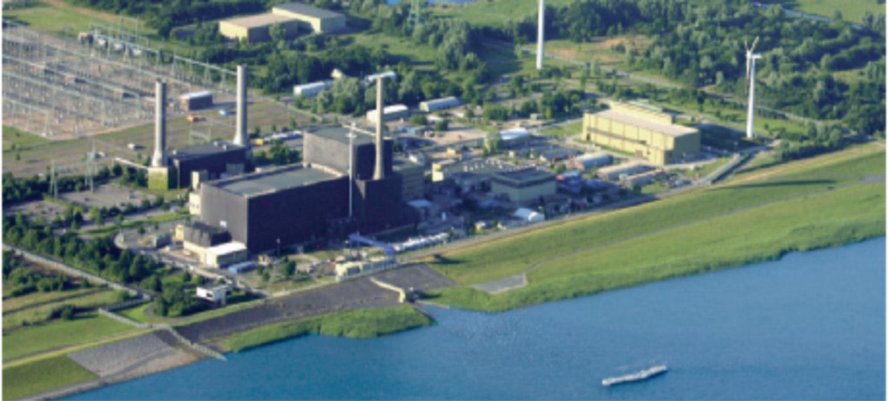
Abbildung 3-1: Kernkraftwerk Brunsbüttel, Fotografie des Kraftwerks von Südwest nach Nordost [VAT 12]
